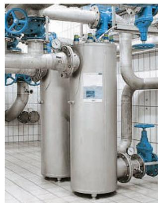
Equipos de alta intensidad de radiación para aguas con baja transmitancia y para agua fría sanitaria, disponen de control de todas las funciones, sensor UV, salida 0-4 20mA, indicadores de alarmas y sonda de temperatura. Fabricados en acero inoxidable AISI 316 TI y especialmente adecuadas para:
